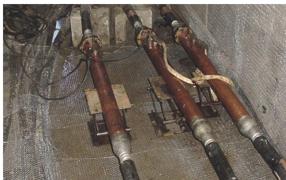
Figure 119 - Equipotential area using wire mesh
