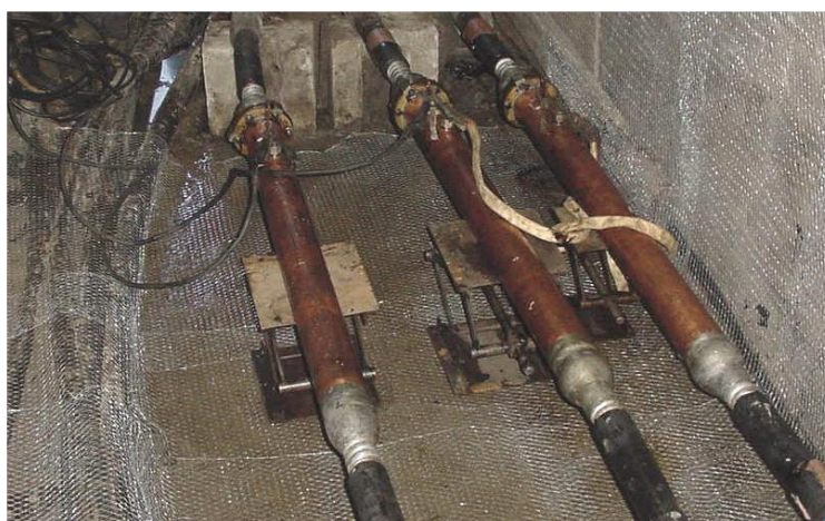
Figure 82 - Equipotential zone using wire mesh
